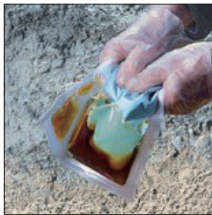
2. 將透明兩色混合包中間的隔膜擠破。
