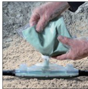
6. 混合物通過專注出口倒入接頭，安全方便。
